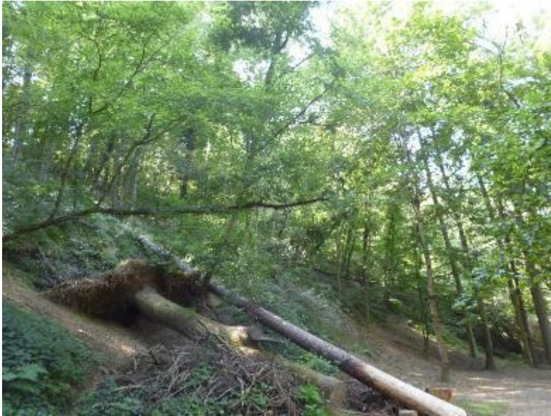
Chute d'arbres et coupe dans les pentes boisées, chemin des amoureux
