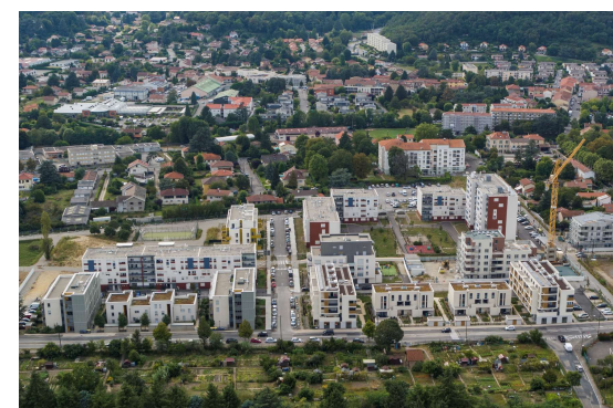
Vue aérienne – Bâtiments réhabilités
